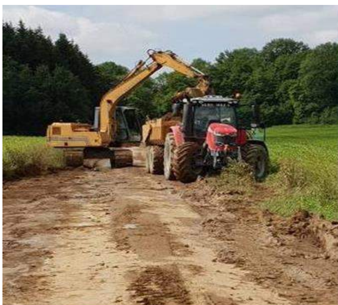
Evacuation de la terre route de Champagny et rebouchage des défauts au blowpatcher
