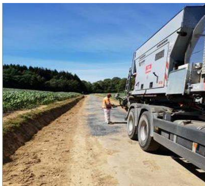
Evacuation de la terre route de Champagny et rebouchage des défauts au blowpatcher
